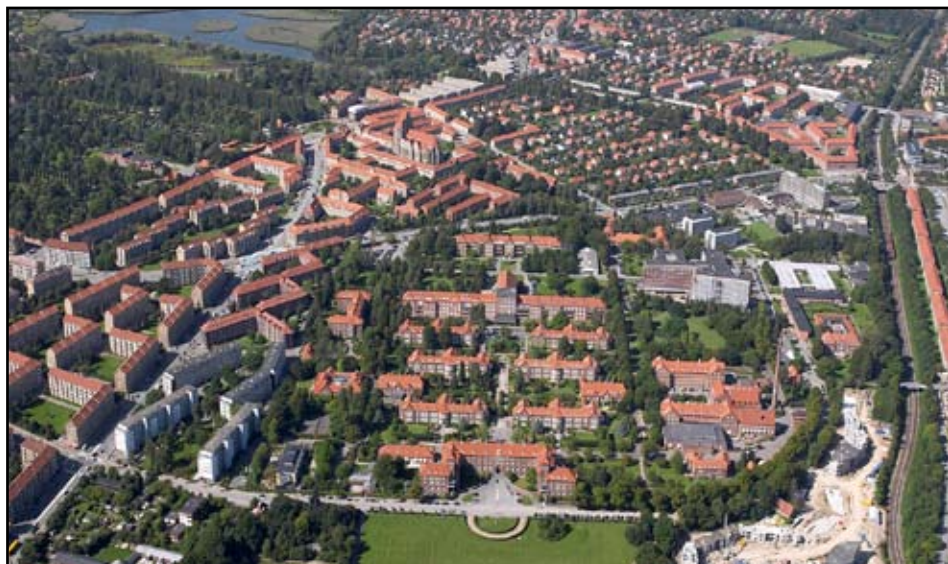
Luftfoto: I pavillonerne på den sydlige del af området skal psykiatrien have ambulansbehandling. På den nordlige del opføres bl.a. en ny, fælles akutmodtagelse. I alt nybygges ca. 121.000 m 2 og renoveres 96.000 m 2 . Foto: JW Luftfoto.
