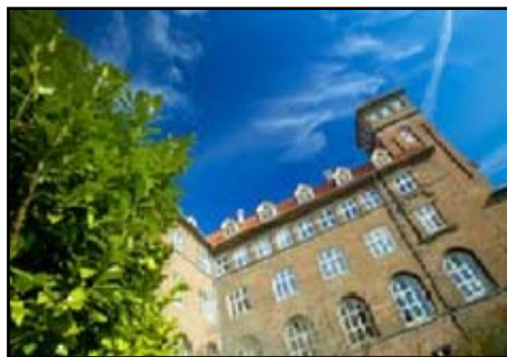
Martin Nyrops smukke pavilloner fra 1913 er blevet fredet, og det bliver en balancegang at renovere og gøre dem tidssvarende. Foto: Claus Peuckert.
